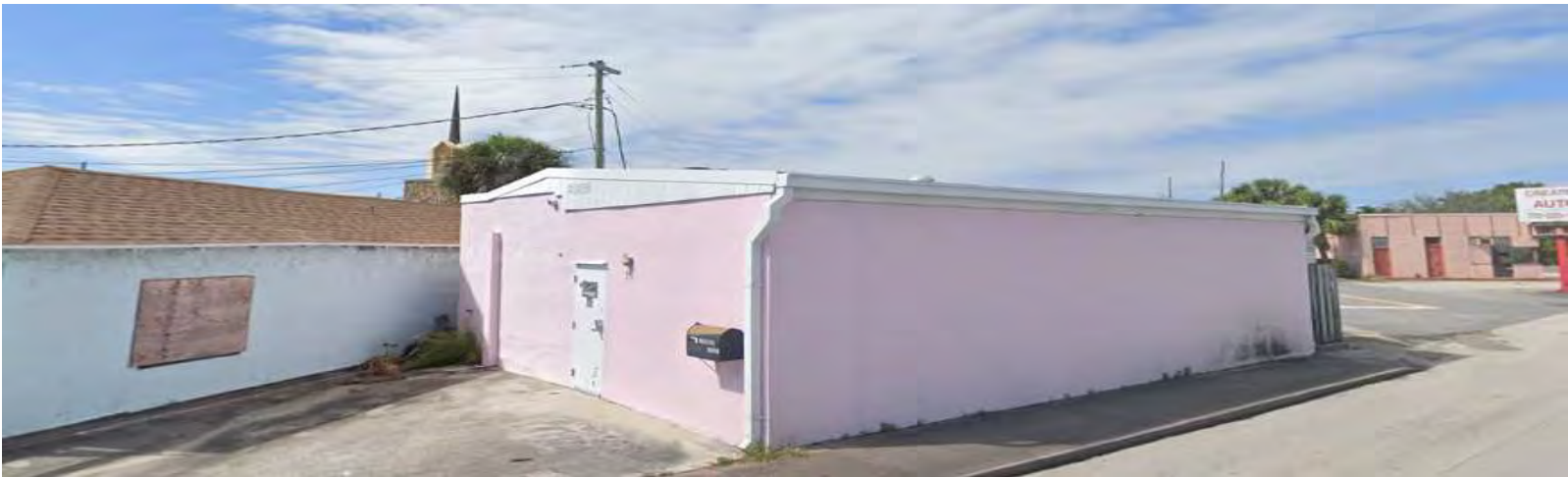
#20 290 SW Dixie Hwy PCN: 053841014013000108
